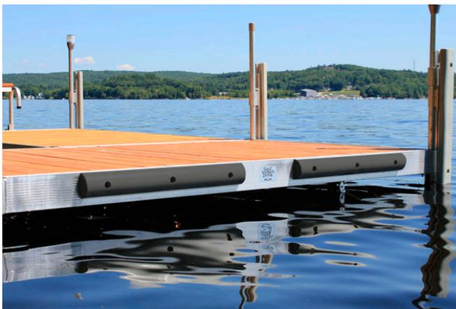
Defensas para muelle y embarcaciones están diseñadas para utilizarse como tope de impacto de vehículos o embarcaciones como remolcadores, balleneras y botes.
